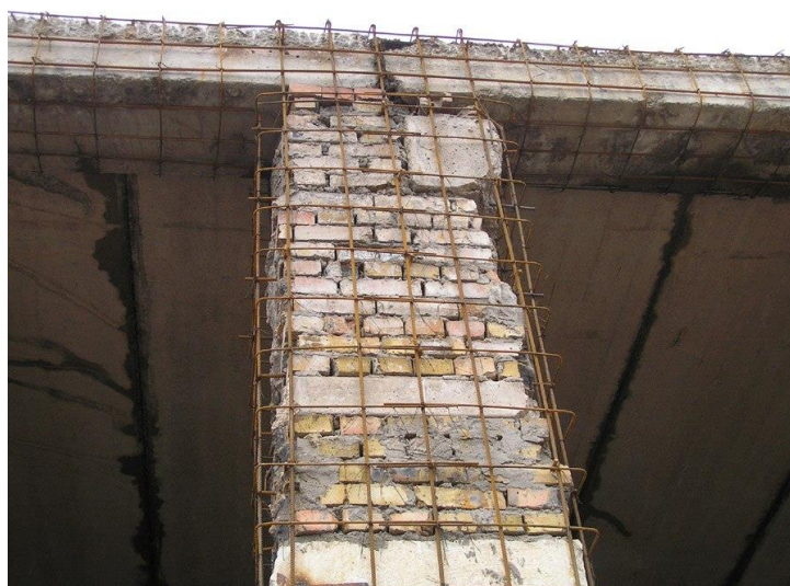
Рисунок 4 – Вариант железобетонной обшивки
