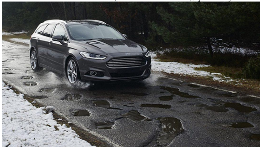
Рисунок 3. Участок с плохими дорожными условиями
