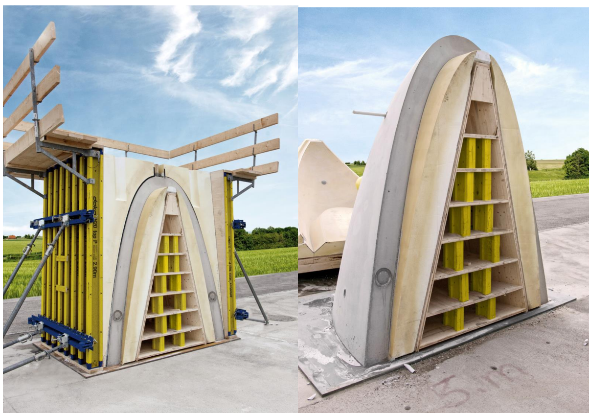
Рис. 1. Трехмерная опалубка DokaShape:
