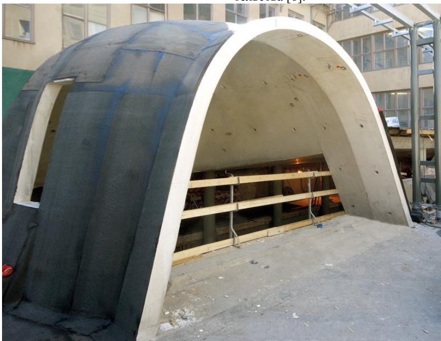
Рис. 3. Конструкция монолитного купола во время нанесения гидроизоляции.
