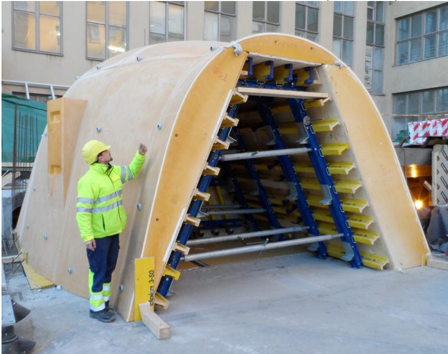
Рис. 2. Конструкция опалубки монолитного купола.
