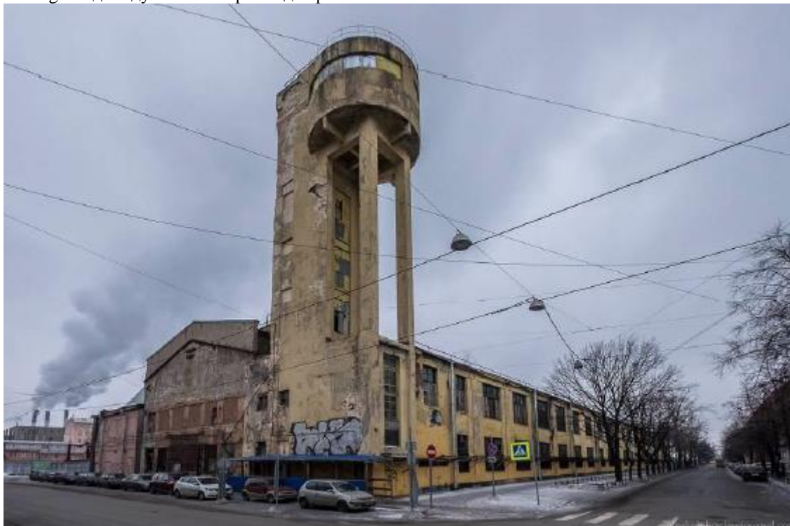
Рис. 1 Фотофиксация методом Объекта объектах до реставрации работ и приспособления
